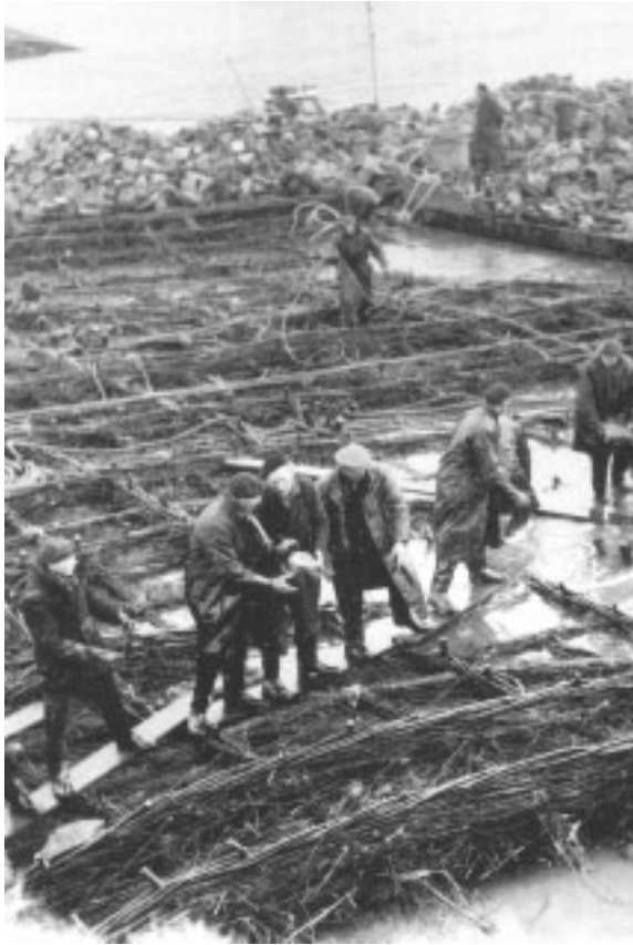
FIG. 3 A willow mattress being sunk. (Kees Slager, De Ramp: Een reconstructie [Goes, 1992].)
